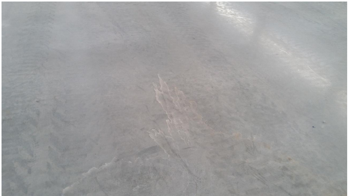
Figura 53 - Patologia Superficial: Manchas Estriadas
