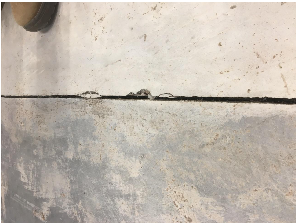
Figura 56 - Esborcinamento e degrau de juntas
