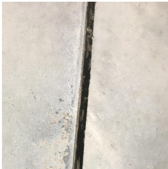
Figura 15 - Junta de construção
