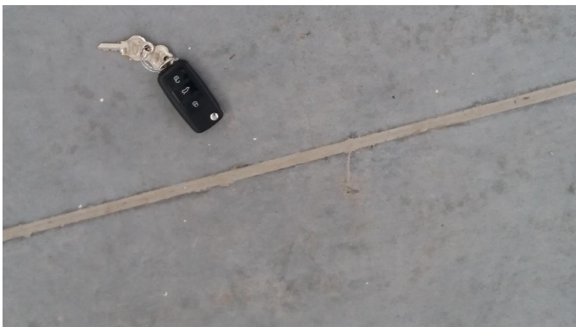
Figura 58 - Fibra exposta no piso interno
