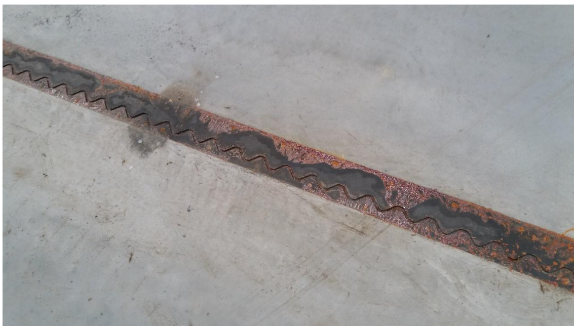
Figura 61 - Oxidação do reforço metálico
