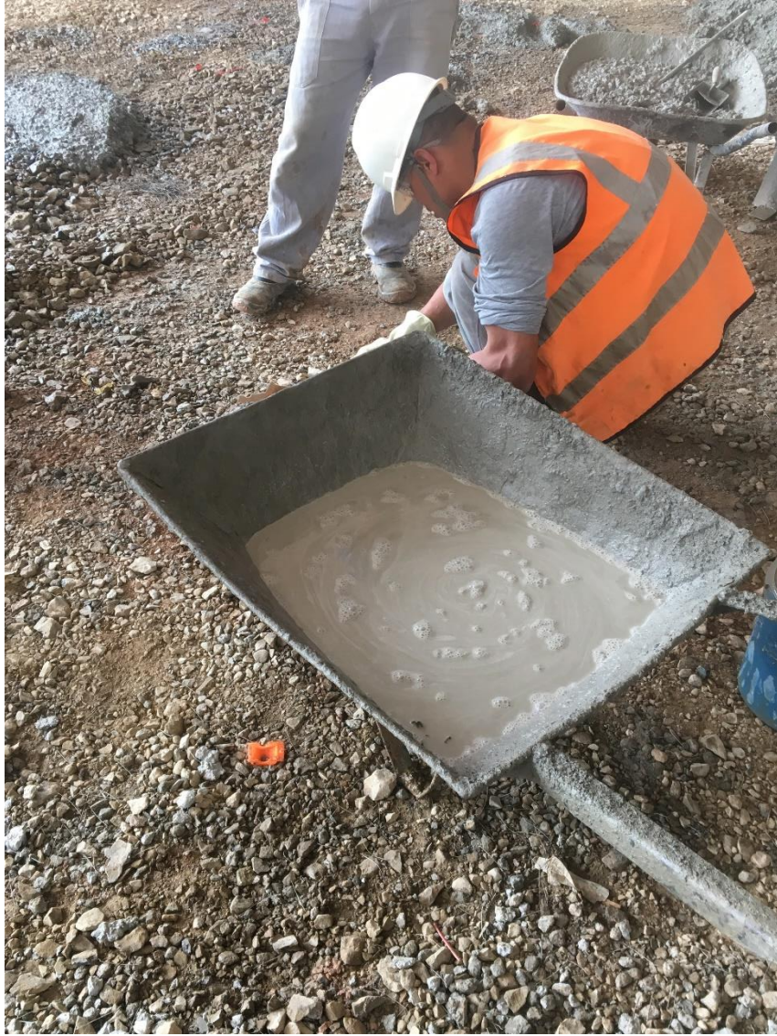
Figura 48 - Mistura da massa com água
