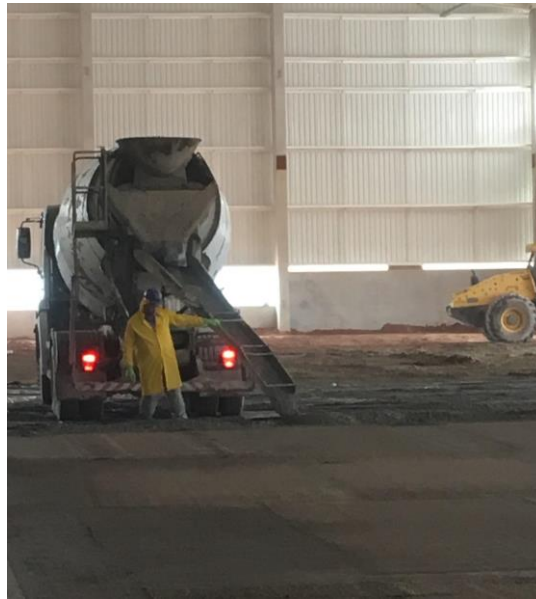
Figura 40 - Despejo de concreto
