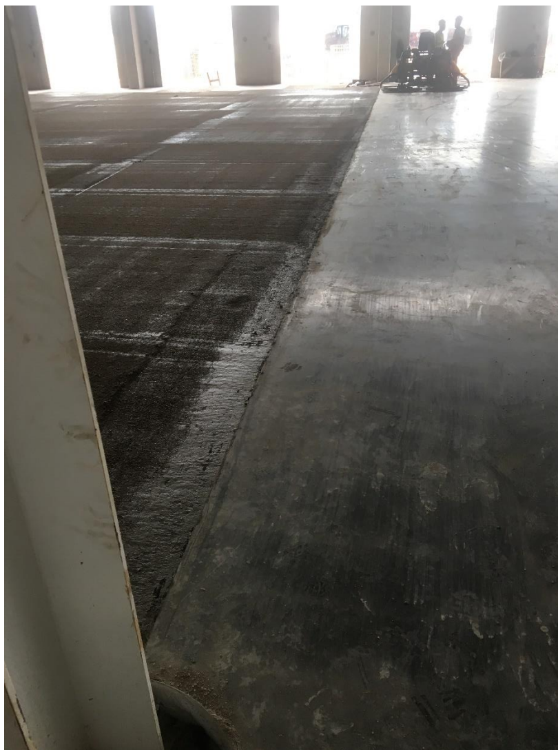
Figura 4 - Limitação entre o piso finalizado e em execução
