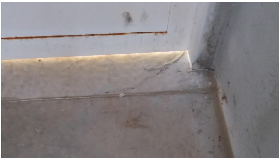
Figura 60 - Fissura de canto na porta de saída
