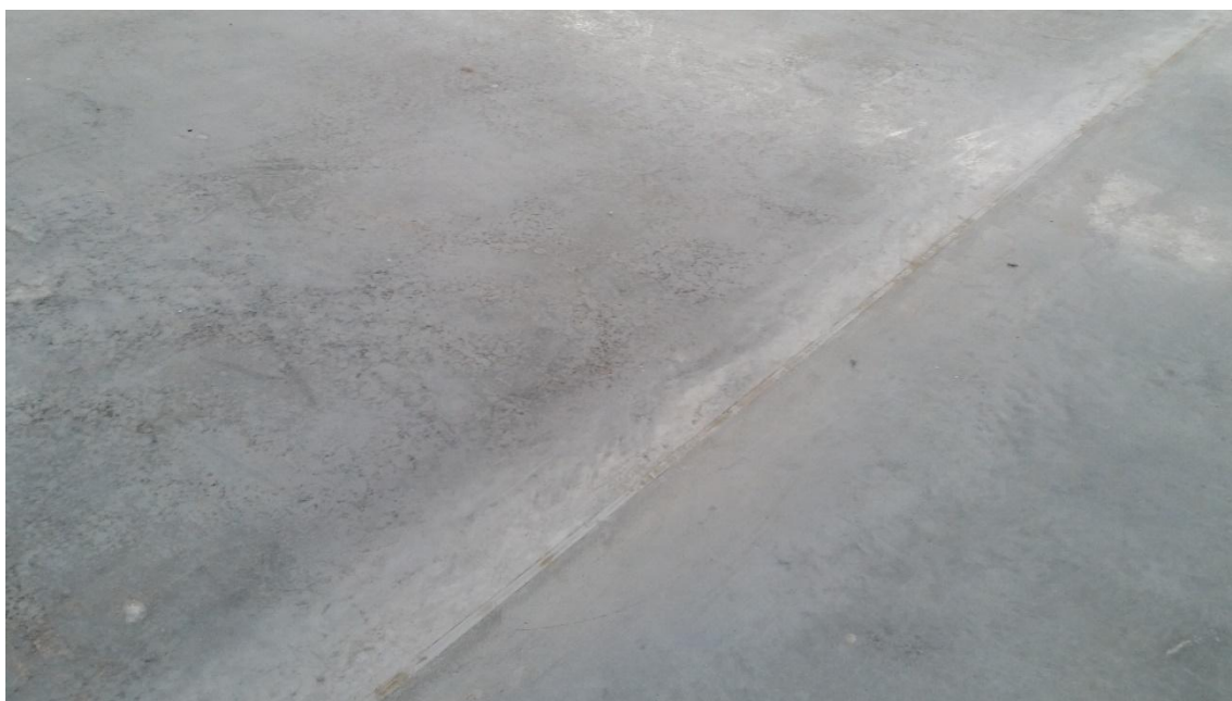
Figura 55 - Placas com diferentes tempos de concretagem
