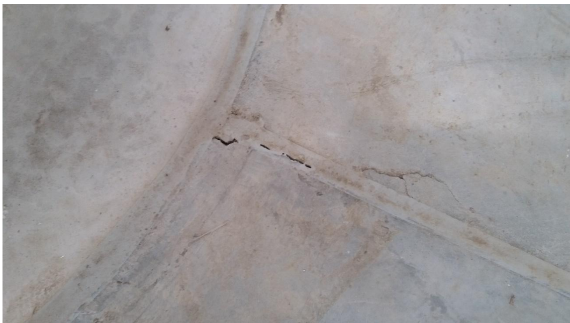
Figura 59 - Fissura no encontro entre placas e pilar
