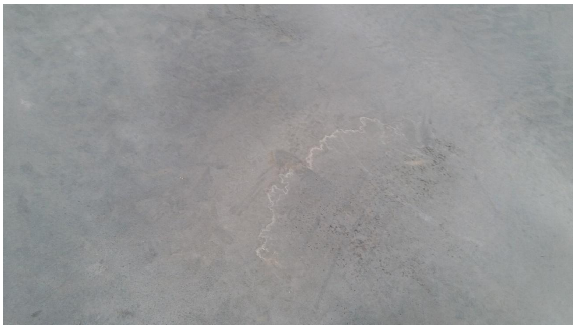
Figura 54 - Patologia Superficial: Manchas Estriadas
