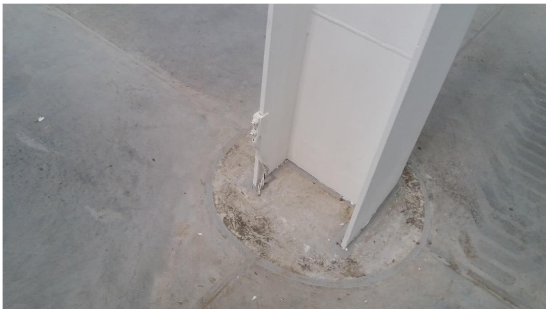
Figura 19 - - Detalhe e projeto: Perfil da junta de encontro
