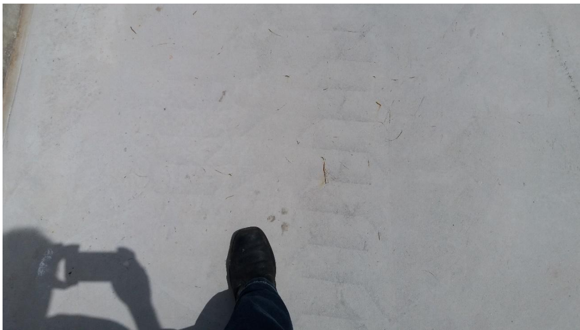
Figura 57 - Fibras expostas na rampa de acesso
