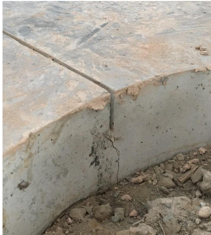
Figura 17 - Junta serrada
